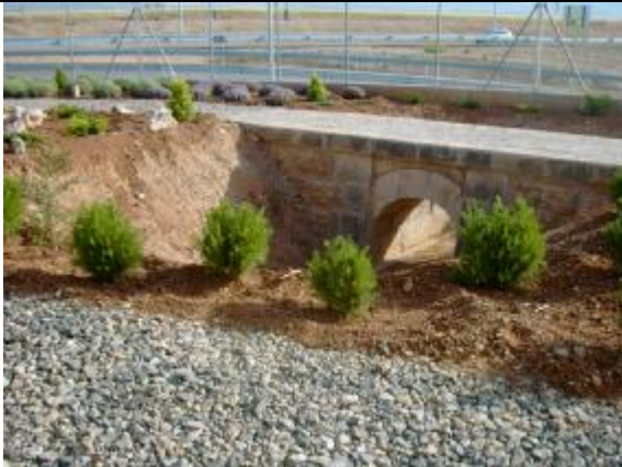
Jardín trasero y pequeña obra de fábrica
