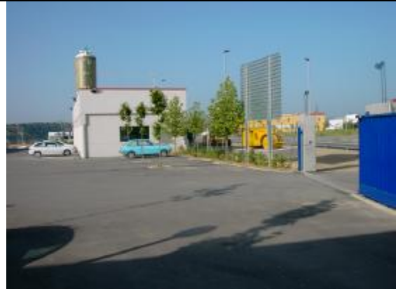
Vista de la entrada al Centro, nave-laboratorio y silo de fundentes.
