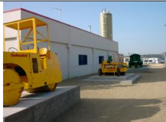
Exterior del Centro, y nave de Laboratorio de la Unidad de Carreteras.
