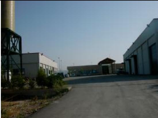
Vista general: A la izquierda, silo de sal, planta de salmuera y nave-laboratorio; a la derecha, nave de maquinaria. Al fondo, edificio principal y de oficinas.
