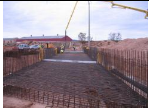
Armaduras de un pontón en construcción.
