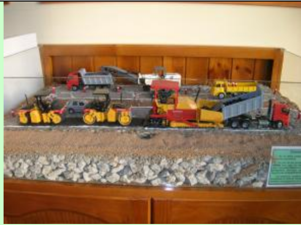
Maqueta de un fresado y reposición de la capa superior de un firme
