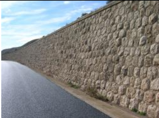
Muro. Carretera N-420. Tortajada (Teruel)
