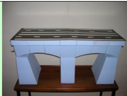
Puente construido por voladizos sucesivos
