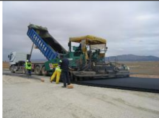
Extendido de aglomerado en una carretera
