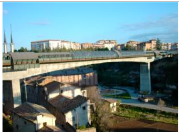
Viaducto nuevo de Teruel (ingeniero: Jesús Irazo). Hormigón pretensado.
