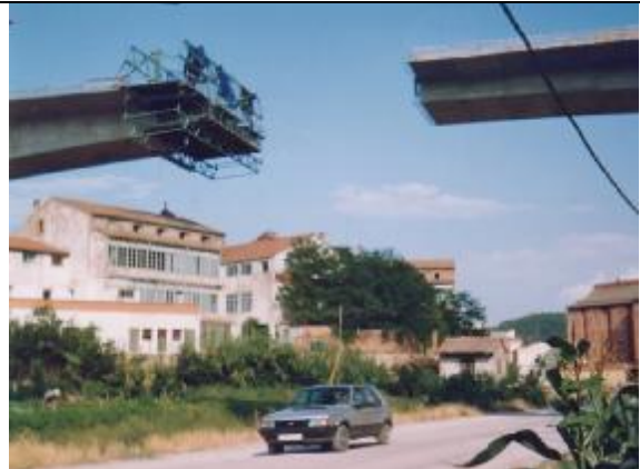
Voladizos sucesivos: Viaducto nuevo de Teruel en construcción.
