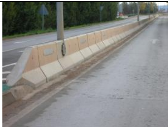
Barrera de seguridad de hormigón (tipo " New Jersey "). Carretera N-223. Polígono La Fuenfresca (Teruel)
