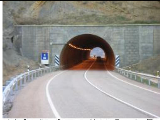
Túnel de San Just. Carretera N-420. Escucha (Teruel)
