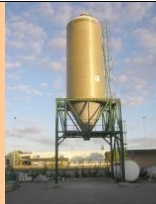
Silo de sal. Centro de Conservación de Carreteras de Teruel. Ministerio de Fomento.
