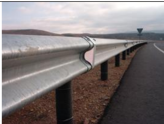
Barrera de seguridad de doble onda (" bionda "), con captafaros. Variante Norte de Teruel.
