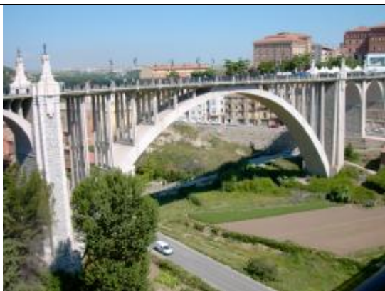
Viaducto antiguo de Teruel (ingeniero: Fernando Hué) El arco central es de hormigón armado.
